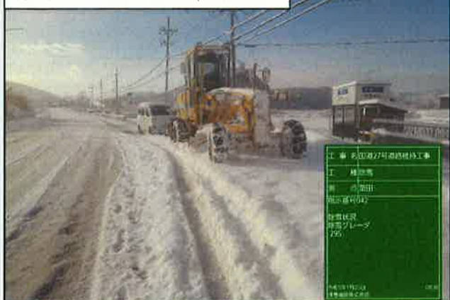
除雪グレーダによる圧雪除雪
